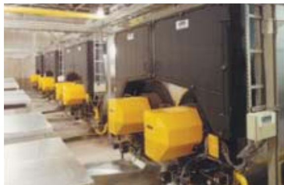
Четыре котла с двумя жаровыми трубами UNIVERSAL ZFR для производства насыщенного пара в параллельном режиме и режиме эксплуатации с одной жаровой трубой
