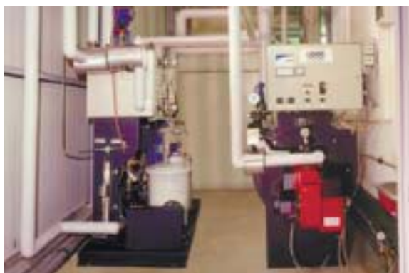
Котел Dampffix DF с деаэрационным модулем WSM-T
